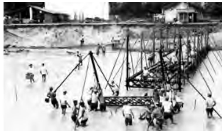
Comunidade engajada na construção emergencial de ponte
